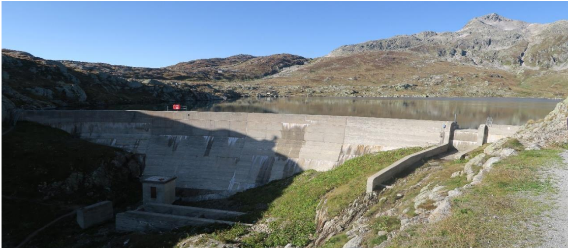
Nádrž Totensee v oblasti priesmyku Grimsel-pass, vytvorená gravitačnou betónovou priehradou vo výške 2 176 m n.m.
