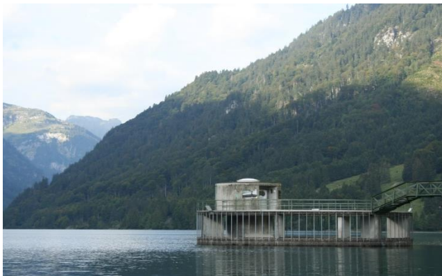
Zemná priehrada Rhodannenberg (jazero Klöntalersee), H_P=30 m, L_K=217 m, výstavba: 1905 – 1908, rekonštruovaná v rokoch 1971 -1975, V_N=39,80 mil. m^3 , V_P=110\ 000 m^3 , S_P=82,82 km^2
