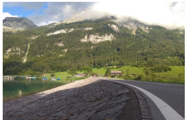
Zemná priehrada Rhodannenberg (jazero Klöntalersee), H_P=30 m, L_K=217 m, výstavba: 1905 – 1908, rekonštruovaná v rokoch 1971 -1975, V_N=39,80 mil. m^3 , V_P=110\ 000 m^3 , S_P=82,82 km^2
