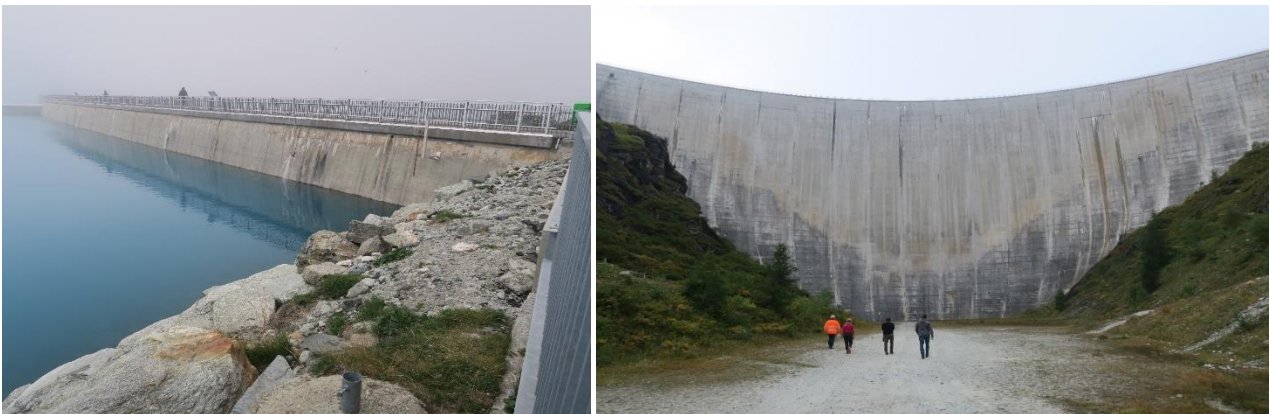
Klenbová priehrada Moiry, H_p = 148 m, L_K = 610 m, výstavba : 1954 – 1958, V_N = 77 mil. m^3 , V_P = 814\,500 m^3 , S_P = 245 km^2
