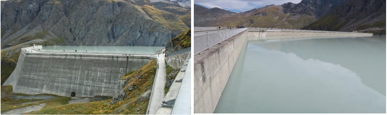
Grande Dixence, najvyššia betónová gravitačná priehrada v Európe, H_p = 285 m, L_K = 695 m, výstavba: 1950 – 1961, V_N = 400 mil. m^3 , V_P = 5\,960\,000 m^3 , S_P = 340 km^2
