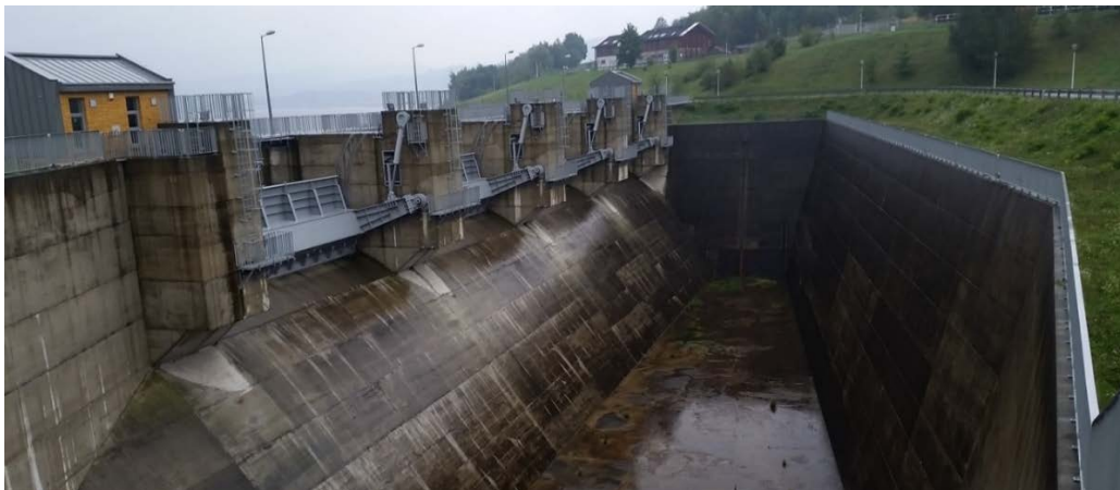
Bočný bezpečnostný priepad hradený segmentami
